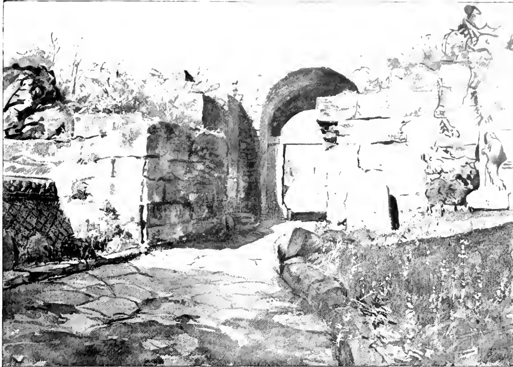
LA PORTE STABIENNE
